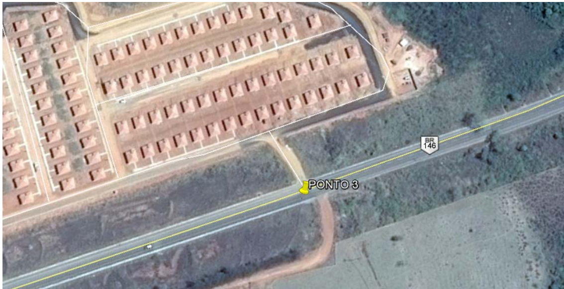
Figura 11 - Ponto 3: Acesso ao condomínio residencial localizado à MG-146, próximo ao km3
