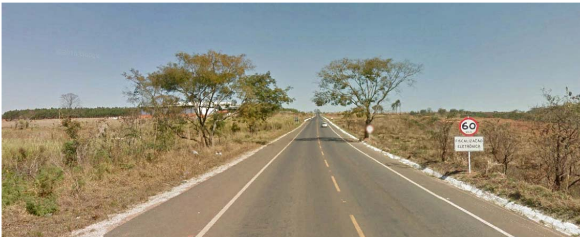
Figura 9 – Vista de uma seção da rodovia MG-146 fora do perímetro urbano.
